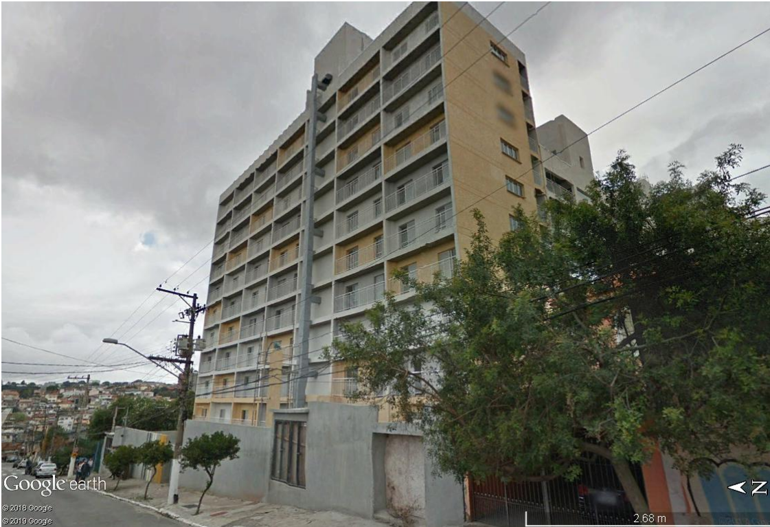
Fachada Rua Coriolano Durand
